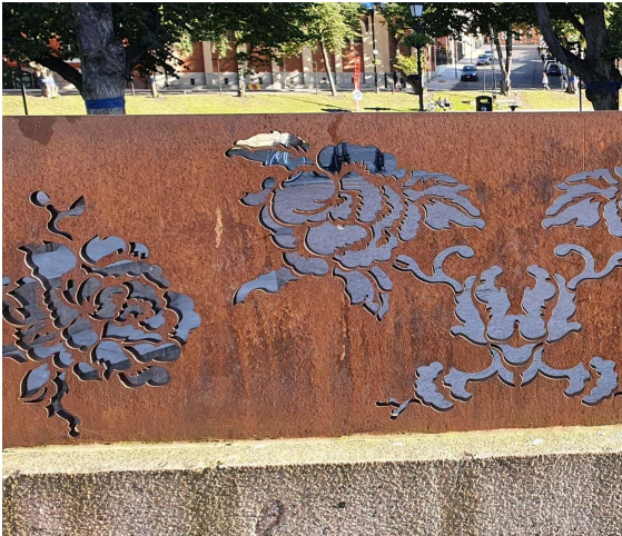
Kuva 6 Laserleikkaus esimerkiksi metallilevyyn voidaan toteuttaa lähes rajattomien mahdollisuuksien. Kuvioinnin suunnittelu toteutetaan ammattitaiteilijoilla. Kuvassa turkulaiseen korten teräksestä muodostettuun aitaan on leikattu ruusukuvia. Taiteilija tuntematon, kuva: Maija Kovari
